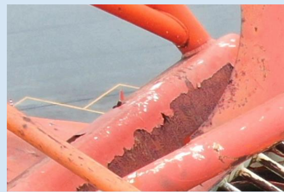
撮影画像を拡大（対象部材の塗装剥がれ）
