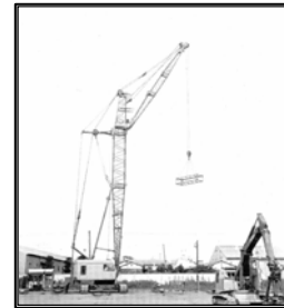
(写真8) タワークレーン (水平引き込み)
