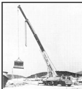
(写真13) クレーン
