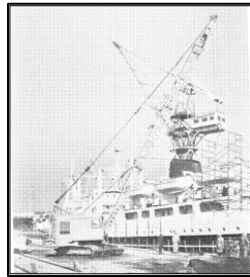
(写真7) クレーン
