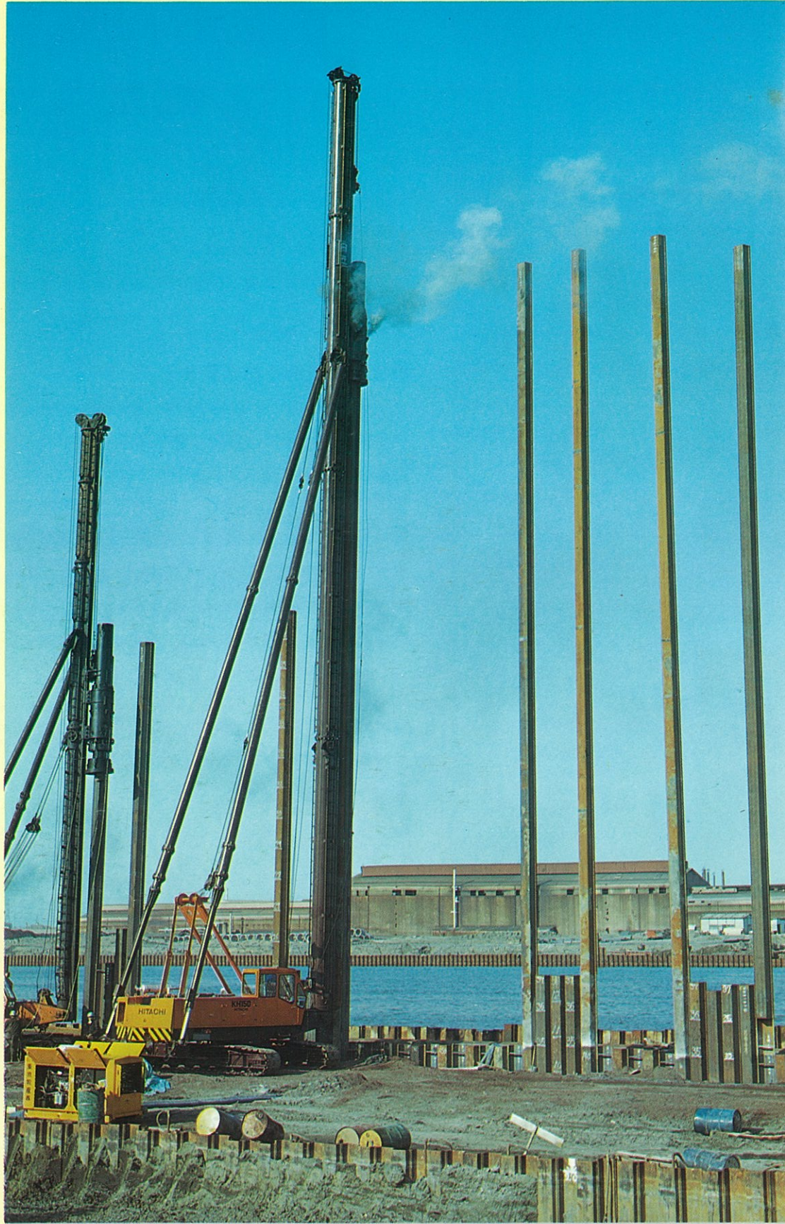
土留工事に活躍する日立KH150直結式パイルドライバ
