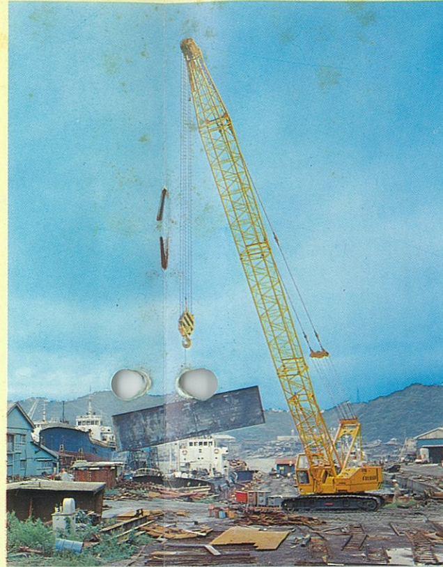
港湾荷役に活躍する日立KH150クローラークレーン
